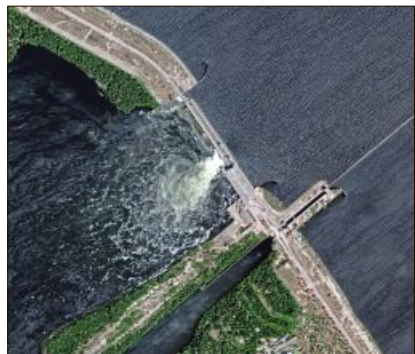
Von oben ist zu sehen, wie Wasser durch ein Loch im Staudamm fließt. Foto: Maxar Technologies/dpa
