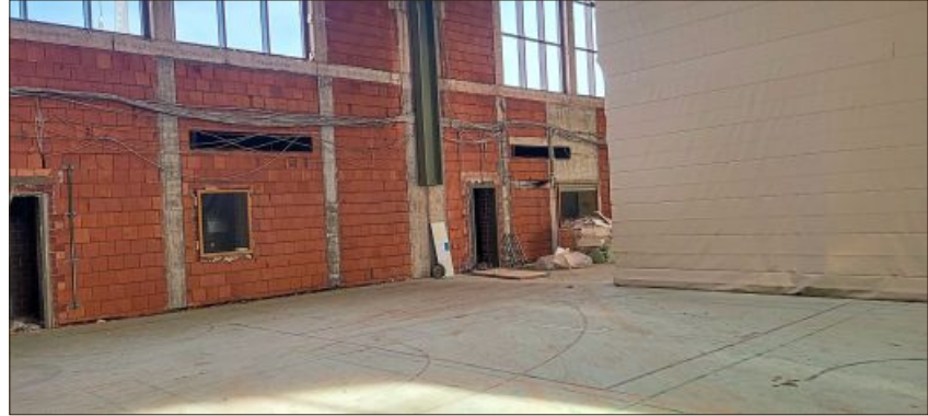
Der Sporthallenbereich ist bereits komplett zurückgebaut.
