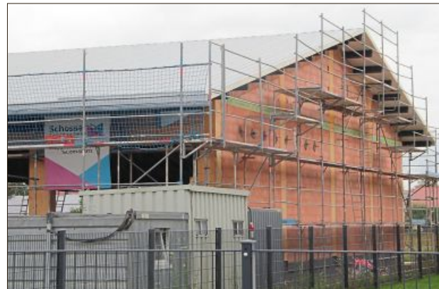
Das zeitgemäße Bauhofbetriebsgebäude am Südvicus soll Ende Oktober bezogen werden.
